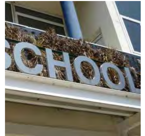
本物の植物と灌水装置で設置されたが枯れてしまった例
